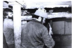
Das Wechseln eines Balkens
