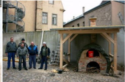
Der Bau des Daches wurde von der Teutloff realisiert
