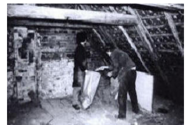
Der Boden wird ausgebaut
