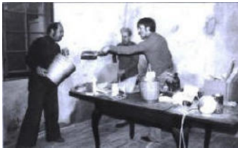
Renovierung von Raum 1
