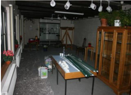
Die Malerbaustelle "Neue Galerie"
